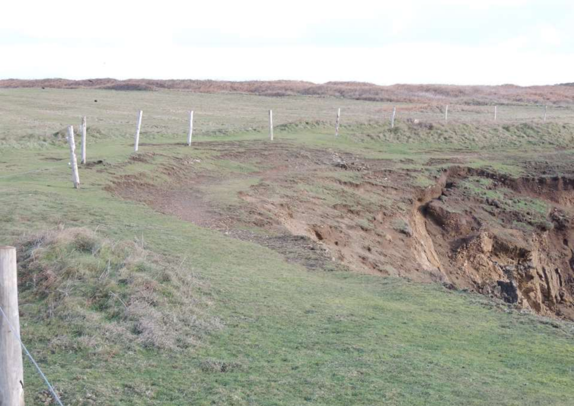
Erosion liée aux tempêtes
